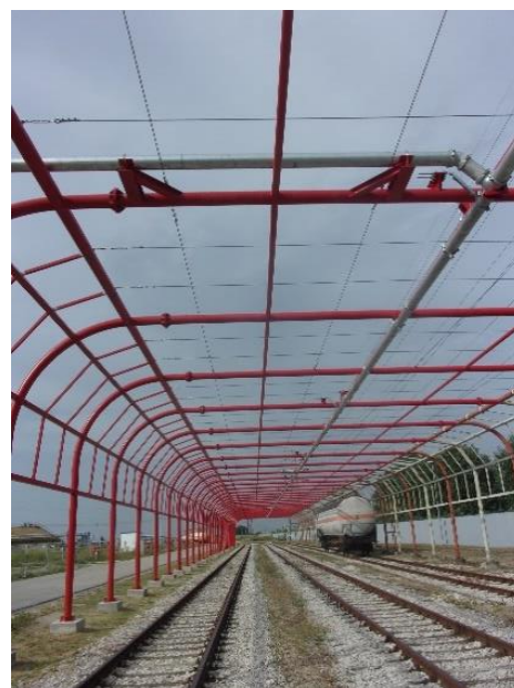
Figura 18 Foto raddoppio rete antincendio e protezione metallica area sosta ferrocisterne.
