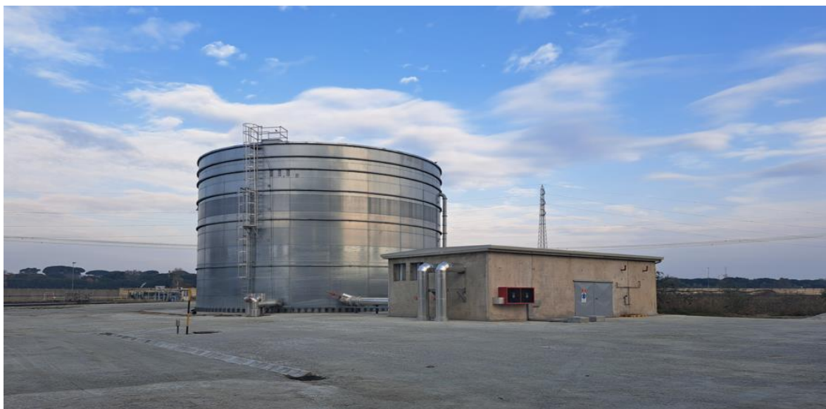
Figura 26 Serbatoio di accumulo dell'acqua antincendio e stazione di pompaggio
