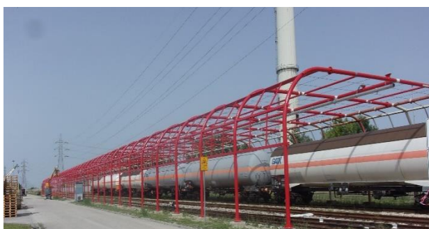
Figura 18 Foto raddoppio rete antincendio e protezione metallica area sosta ferrocisterne.
